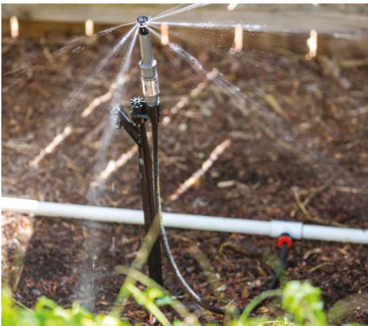
Instalación de la MP-STAKE-PSR40-CV
